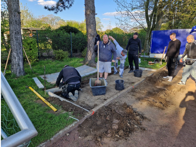
Fundamentverlegung für unser neues Holzhaus
